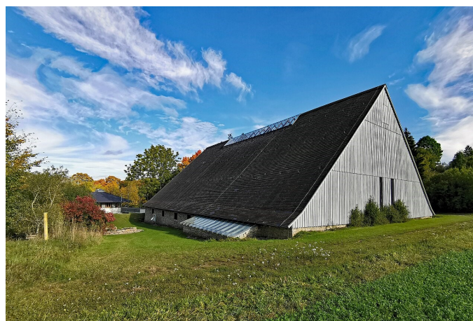
Schutzbau der römischen Badruine, Brigobannis Hüfingen
